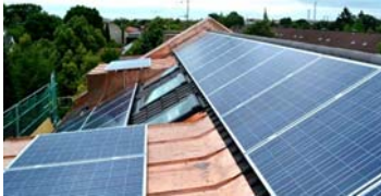
Bestandbau in München-Sendling erzeugt Energieüberschuss
